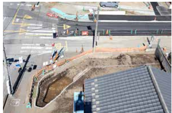
上空から見た町北遺跡 5 区(南から)
