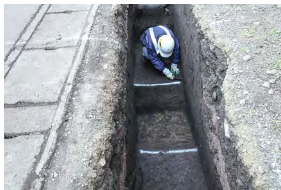
推定東山道駅路 南側側溝(南から)
