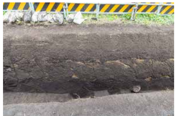
北部As-B下復旧坑断面(西から)
