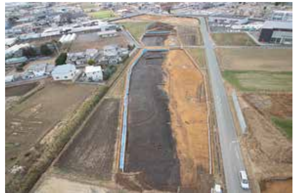
古墳時代の2号開削状遺構全景(北から)
