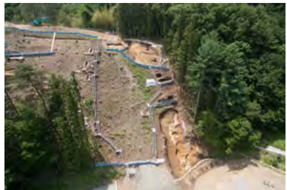
北側斜面全景(北から)
