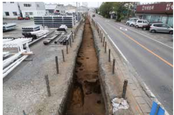
古墳～平安時代の竪穴建物と土坑・ピット群全景(東から)
