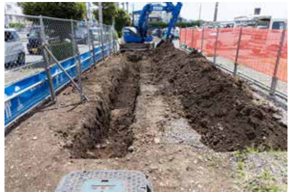
トレンチ掘削状況(西から)
